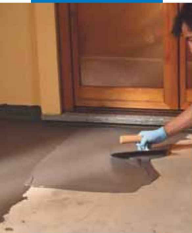
Impermeabilización de arqueta de hormigón a brocha
