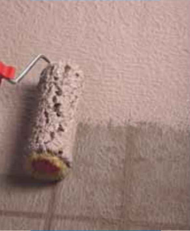
Impermeabilización de muro de cimentación a rodillo
