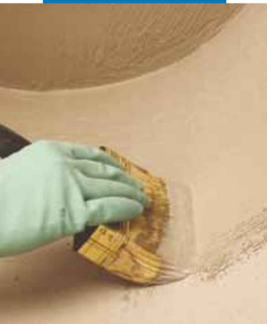
Impermeabilización de muro de cimentación a brocha
